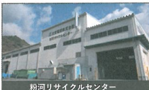
粉河リサイクルセンター
